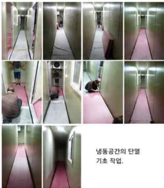
*바닥 수평 작업후 베네폴로 바닥을 열고 SOT 어이스팅크를 설치합니다.
