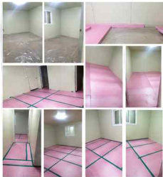
*바닥 수평 작업후 베네폴로 바닥을 열고 SOT 어이스팅크를 설치합니다.
